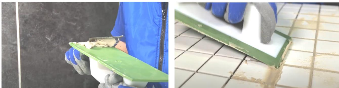
Рис. 19. Заполнение швов затиркой при помощи резинового шпателя
